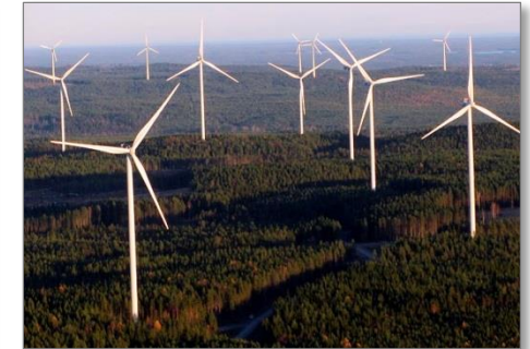
Jädderåsen Wind Farm (Arise, Sweden)
